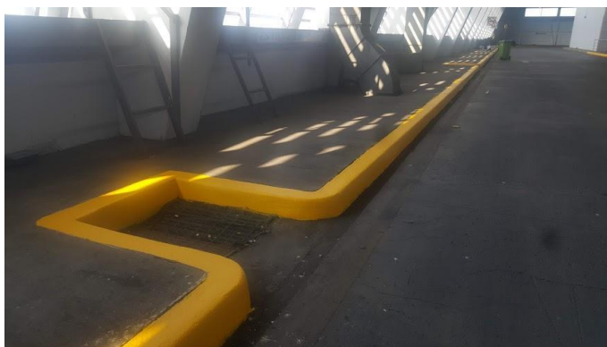
Gráfico 48 Pintura en bordillos de andenes de llegada y salida
